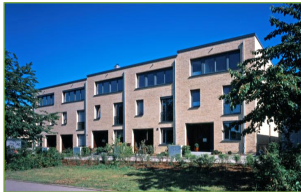
Hannover-Kirchrode Reihen- und Doppelhäuser in der Elly-Beinhorn-Straße
